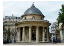
The Barrière de Chartres Rotunda, by Claude-Nicolas Ledoux, for the Wall of the Ferme générale, 1786-1792, parc Monceau, Paris.
