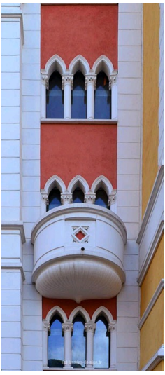
Front detail, château des Ollières.
